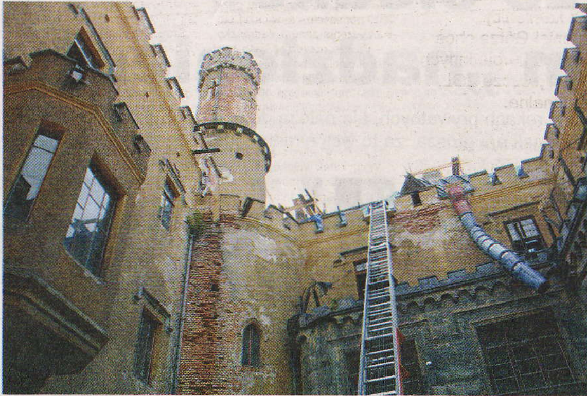
Pałac zostanie wyremontowany w ciągu 3 lat.
